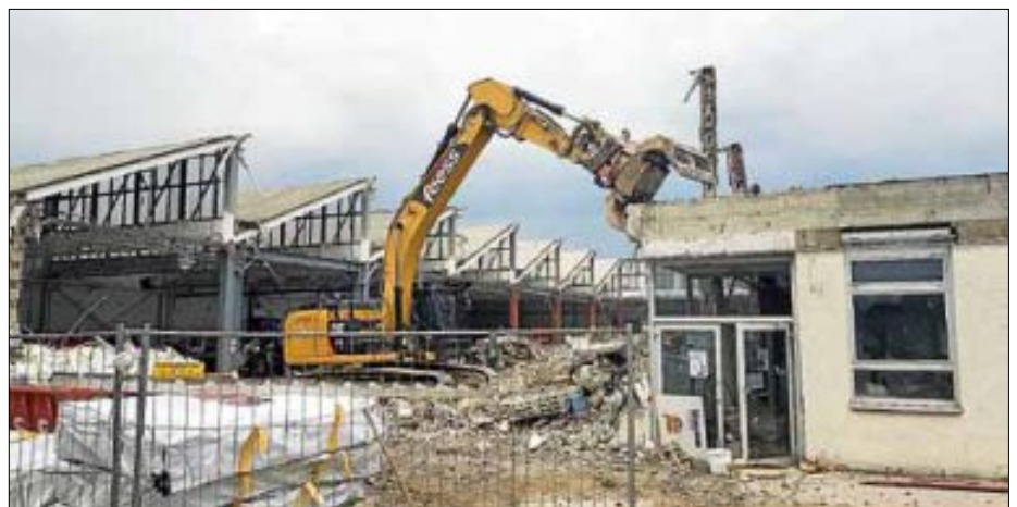
Der Abrissbagger in Aktion
