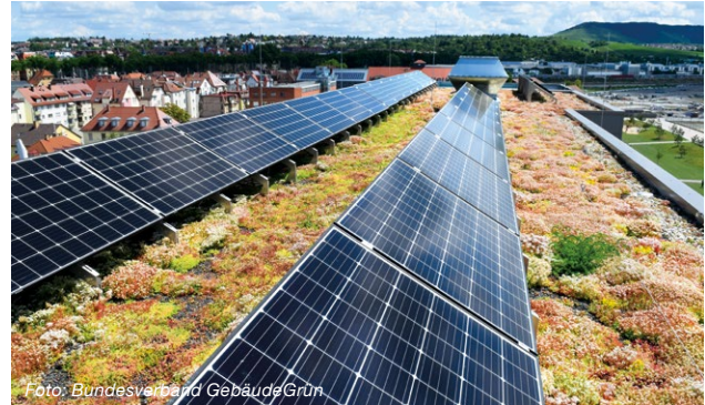
Abbildung 3: Photovoltaik und Gründach sind unmittelbar auf der selben Fläche verbunden. Hier sind die Module in eine Richtung ausgerichtet.
