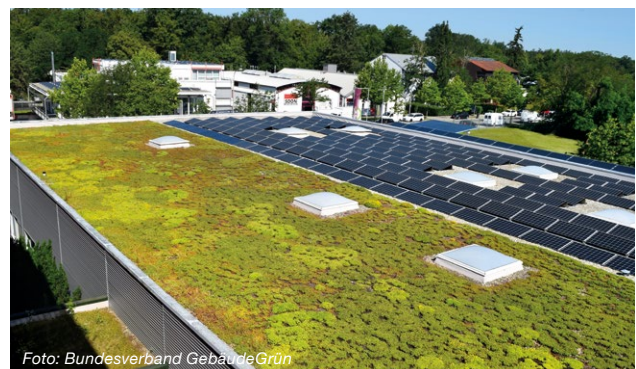
Abbildung 6: Konzept der räumlichen Trennung von Sonnenstromerzeugung und Dachbegrünung in Freiburg umgesetzt.
