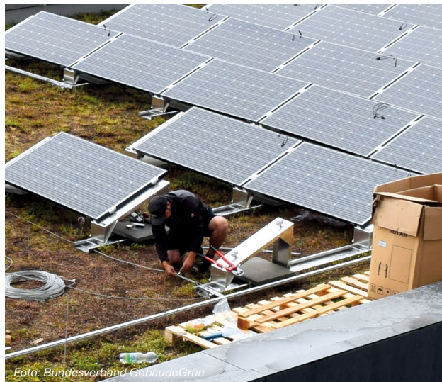
Abbildung 7: Montage einer PV-Anlage auf ein bestehendes Gründach.
