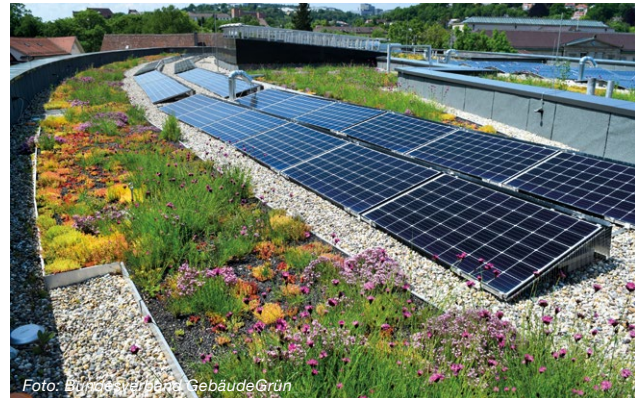
Abbildung 5: Konzept der räumlichen Trennung von Solar-Anlage und Gründach – hier auf dem kommunalen Gebäude der Stadt Tübingen.
