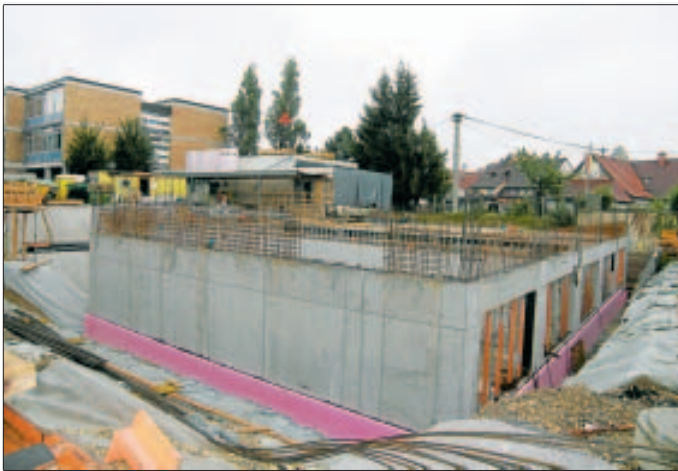
Neubau Turnhalle Gartenschule.
