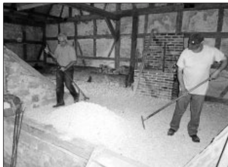
Die Bodenflächen in der Pfarrscheuer werden verfüllt und eingeebnet.
