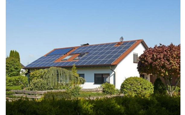
Dach (Süd, SW, SO...)
