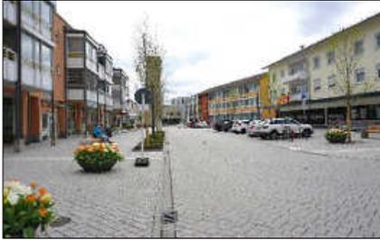
Der Baubeginn in der Albstraße erfolgte am 9. Mai 2022. Mit der Neugestaltung durch Schaffung eines Platz-Charakters mit einer durchgehenden, nahezu ebenen Fläche und der Einrichtung einer Tempo-20-Zone sowie einer Verschmälerung der Fahrbahn erfolgte eine Verkehrsberuhigung und zugleich eine stadtgestalterische Aufwertung durch breitere Gehwegflächen, viele Sitzmöglichkeiten und zahlreiche Anlehnbügel für Fahrräder.
